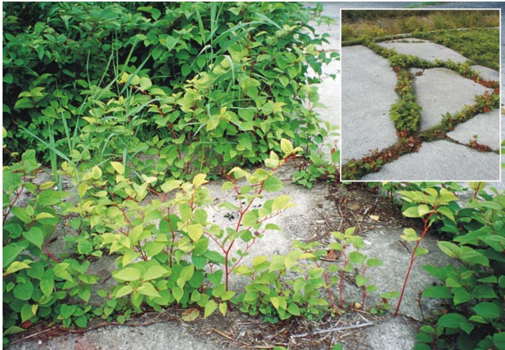
Abb. 21: Im Bereich der Ringbahn auf Langeoog ist Fallopia japonica in der Lage, selbst kleinste Spalten im Beton zu durchwachsen und diese mit der Zeit zu vergrößern.
