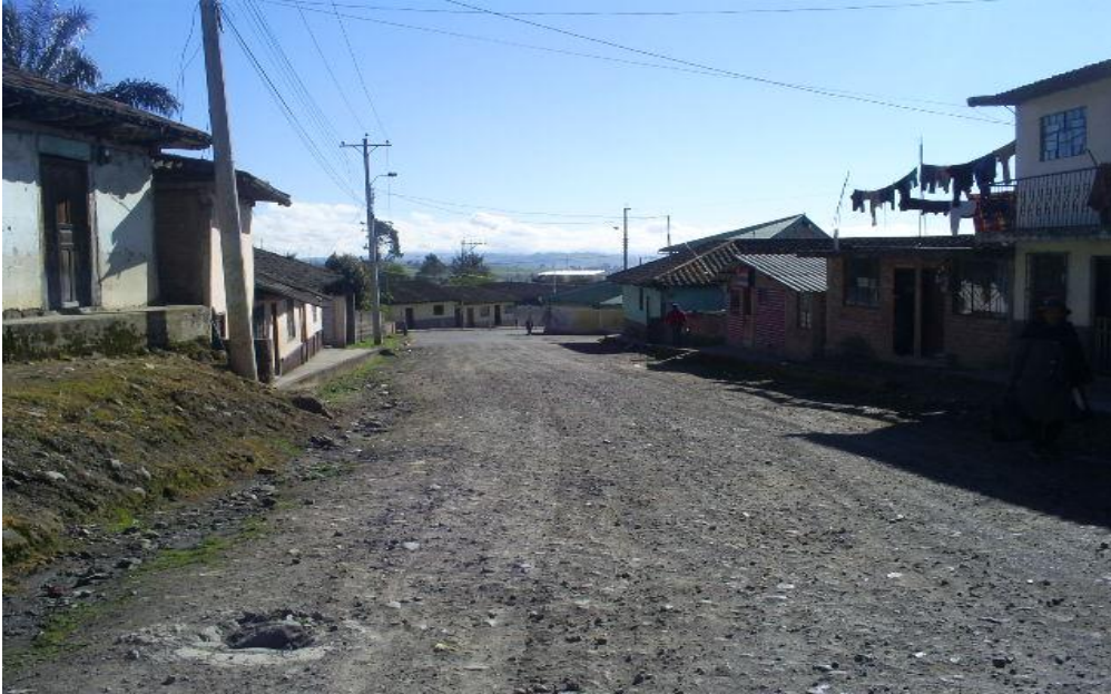
Vista de la vía a la salida de Tufiño a Maldonado
