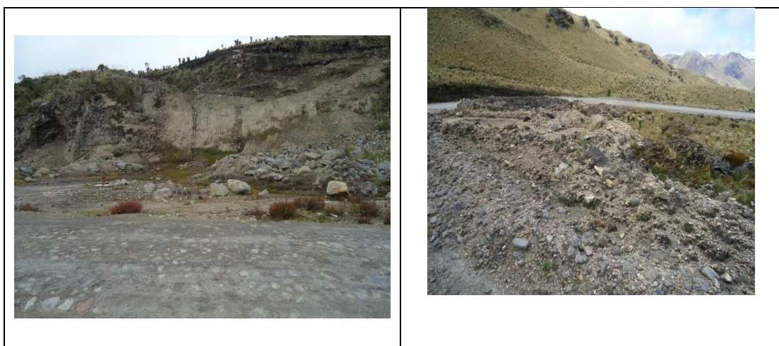
Vía actual con taludes erosionados
