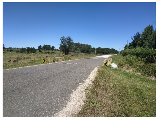
Alcantarilla en Ao. Barboza
