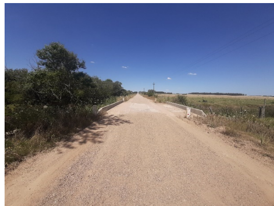
Camino y alcantarilla sobre Ao. Del Cisne
