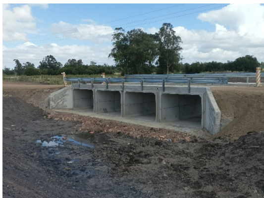
Alcantarilla sobre Cda. Del Chana en etapa final de obra
