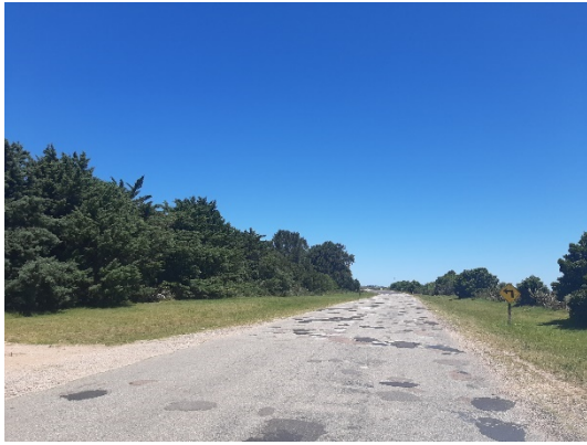
Vista de una sección característica con pavimento, bacheos frecuentes y señalización cercano a ruta N° 9
