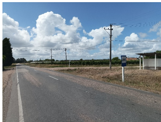
Intersección con ruta nacional N° 107
