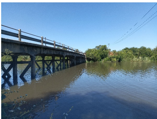
Vista general de la estructura inferior
