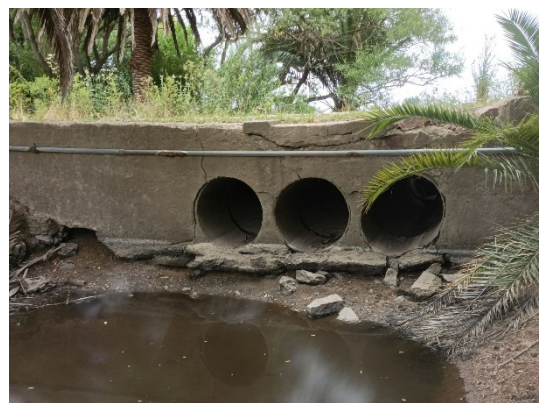
Alcantarilla sobre Ao. De las Brujas Chico
