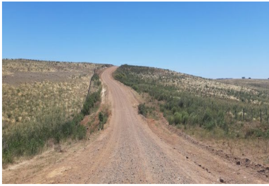
Vista del camino y alcantarillas
