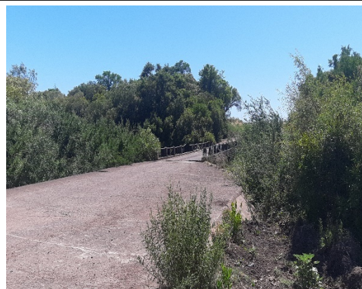
Puente sobre el Ao. Sopas
