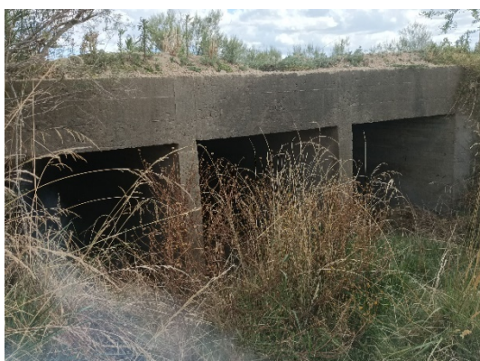
Alcantarilla rectangular de tres bocas
