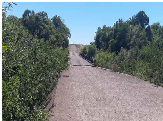
Puente sobre el Ao. Sopas
