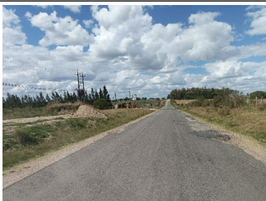
Tramo pavimentado de 500 m desde Raigón
