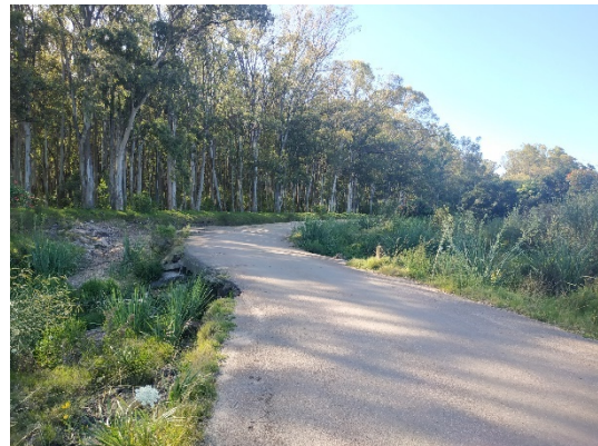
Badén y alcantarilla en Ao. Tarariras
