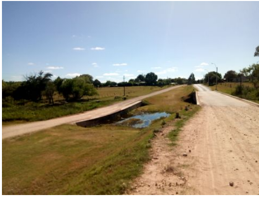
Badén para tránsito pesado y alcantarilla en Ao. Don Esteban Grande, al ingreso de Paso de la Cruz
