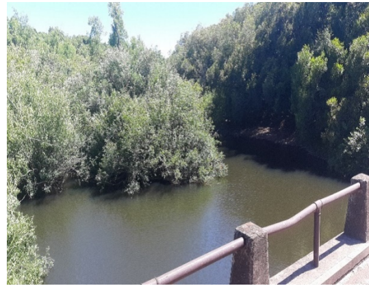
Vista del Ao. Sopas aguas abajo
