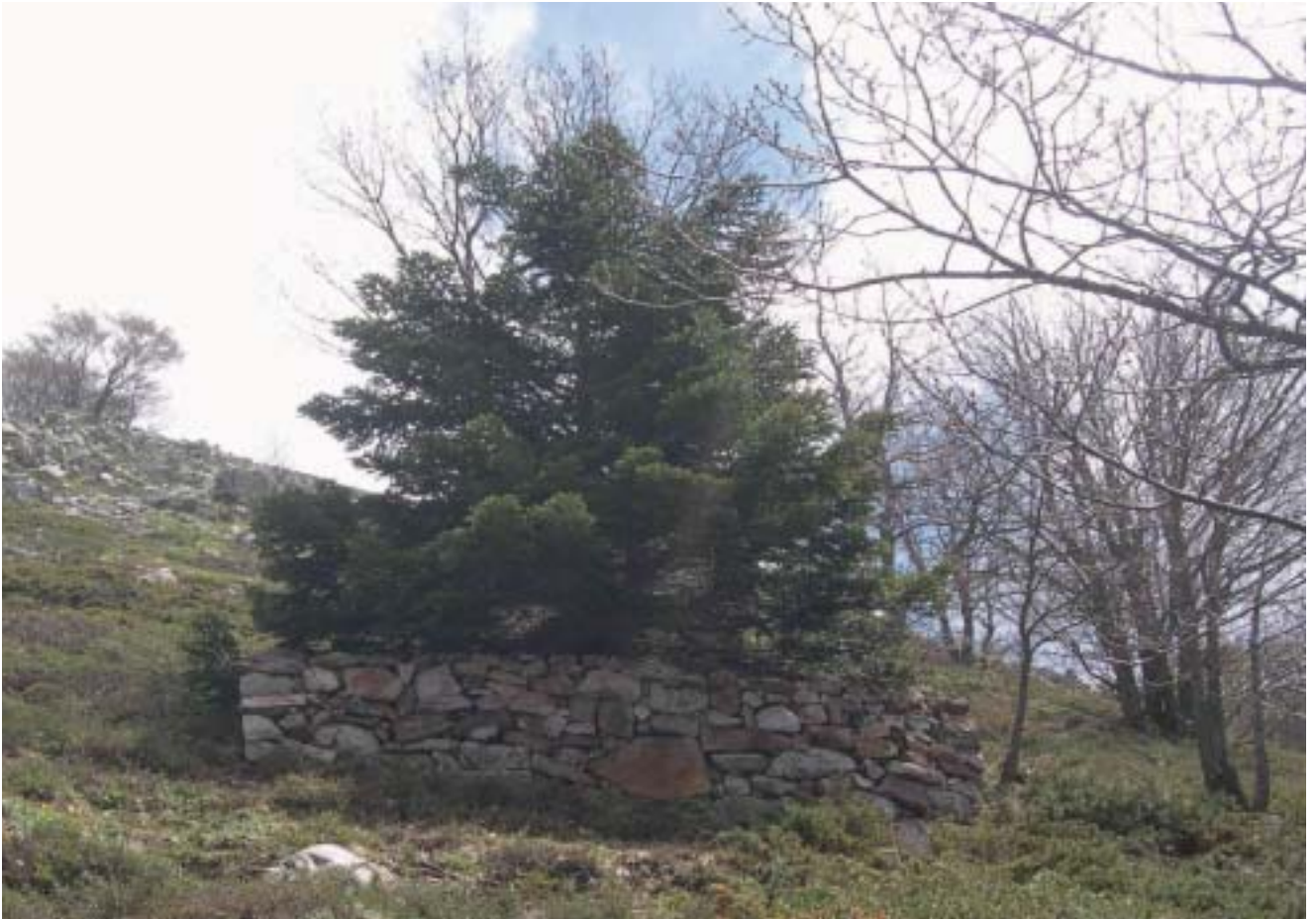
Foto 27 - Pianta n. 15 su un ripiano sostenuto da una tradizionale lunetta in pietrame.
