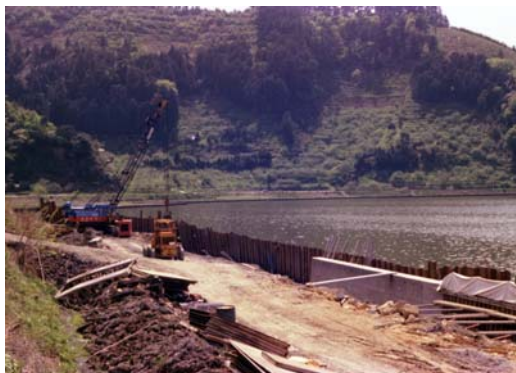
コンクリート護岸工事 (昭和 51 年頃)
