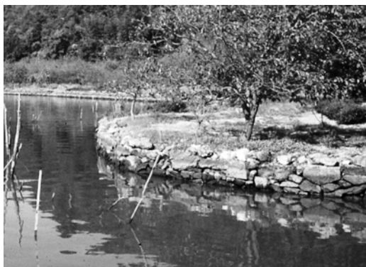
石積み護岸 (昭和 50 年頃)
