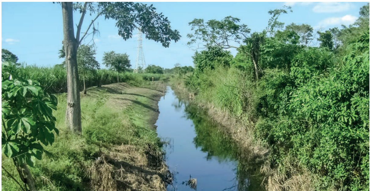
Figura 2. Dren colector en el que se observan taludes con cubierta vegetal herbácea después de tres meses de haber sido desasolvado. Foto: Jesús Manuel Ascencio Rivera.
