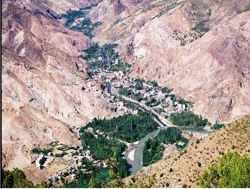
Şekil 2. Yusufeli Barajının inşa edildiği Çoruh Vadisi
