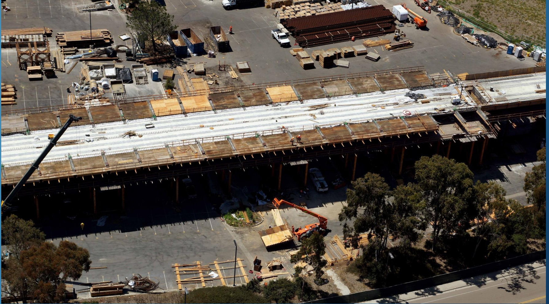
Future Voigt Drive Station
