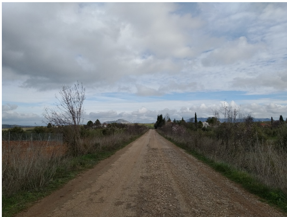
Imagen 6. Pista de acceso a la alternativa nº3
