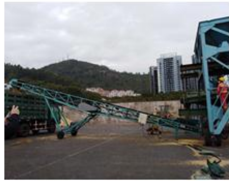
深圳赤湾码头过筛试验现场
