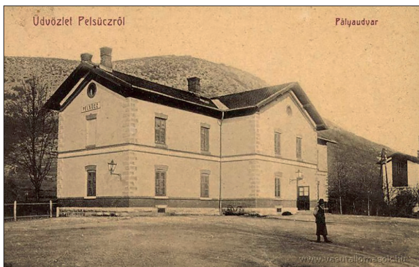
Obr. 6. Staničná budova (postavená v roku 1895) v Plešivci na historickej pohľadnici zo začiatku 20. storočia. V pozadí vidieť južné svahy Plešiveckej planiny. Zdroj: www.vasutallomasok.hu Fig. 6. Station building (built in 1895) in Plešivec on a historical postcard from the beginning of the 20th century. In the background the southern slopes of the Plešivec Plateau can be seen. Source: www.vasutallomasok.hu
