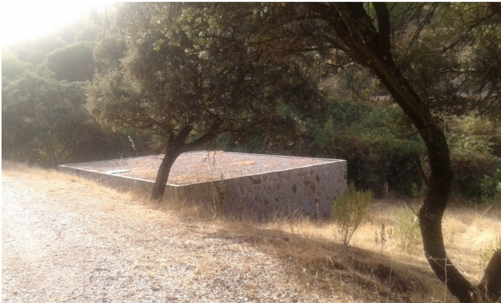
Punto de agua cerrado para la extinción de incendios.
