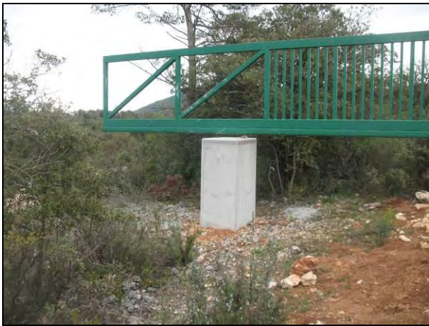
Portail et pilier de soutènement créé en 2010
