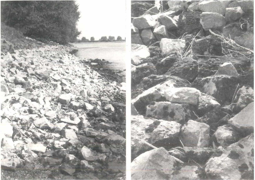
Abb. 1: Trockengefallener Uferstreifen am Rhein bei Oppenheim. Der bei Normalwasser überflutete Bereich ist durch die hellgrauen Steine gekennzeichnet (links). Das rechte Foto zeigt einen typischen Ausschnitt aus einer Blockschüttung der Uferbefestigung mit Cinclidotus -Arten.
