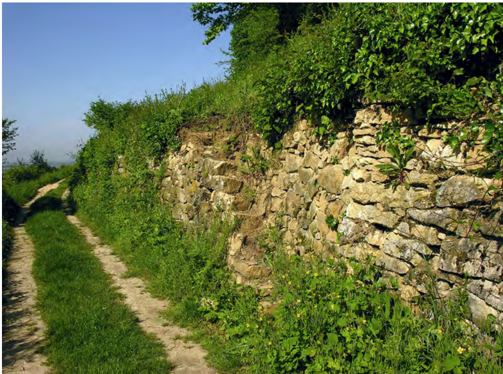
2: Trockenmauer, am Ölberg oberhalb Ehrenstetten.
