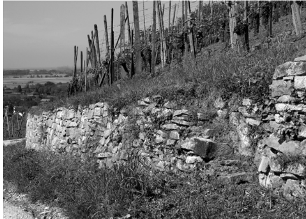
Abb. 3: Erhalten gebliebene alte Weinbergsmauer (Ölberg bei Ehrenstetten).
