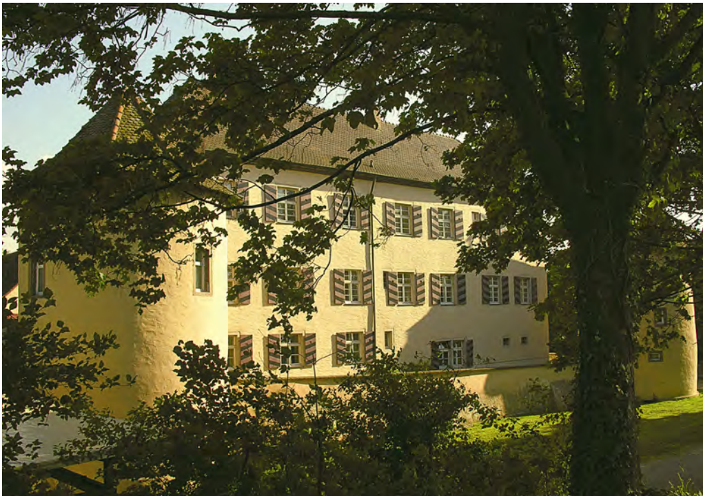
2: Das Wasserschloss zu Kirchhofen – 1416 urkundlich erwähnt, 1740/41 in der heutigen Form erneuert.
