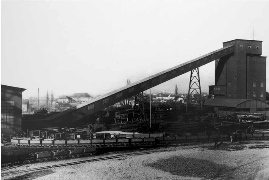
Abb. 15: Roherzsilo in St. Georgen zur Zeit des Betriebs; im Hintergrund sieht man die Gebäude der Schönbergschule (LGRB).
