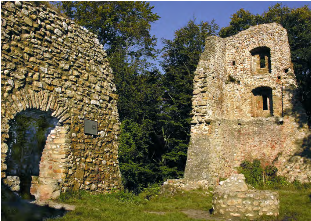
2: Nordwestecke der Schneeberg-Ruine; die Burg war vermutlich schon vor dem Bauernkrieg aufgegeben.
