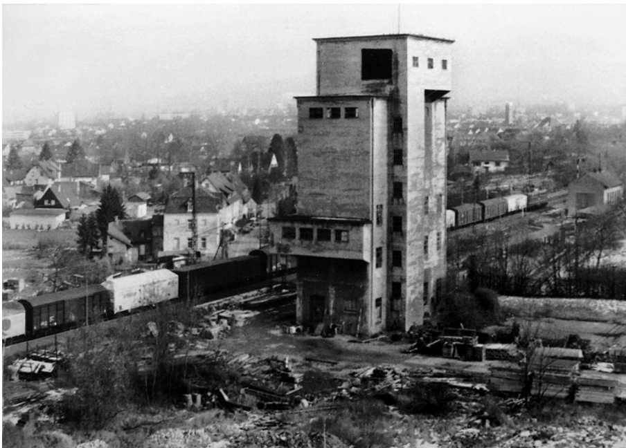
Abb. 16: Roherzsilo in St. Georgen, Verladestation nahe der Bahnstation für den Weitertransport des Erzes mit der Reichsbahn; die Anlage wurde 1980 abgebaut (LGRB).
