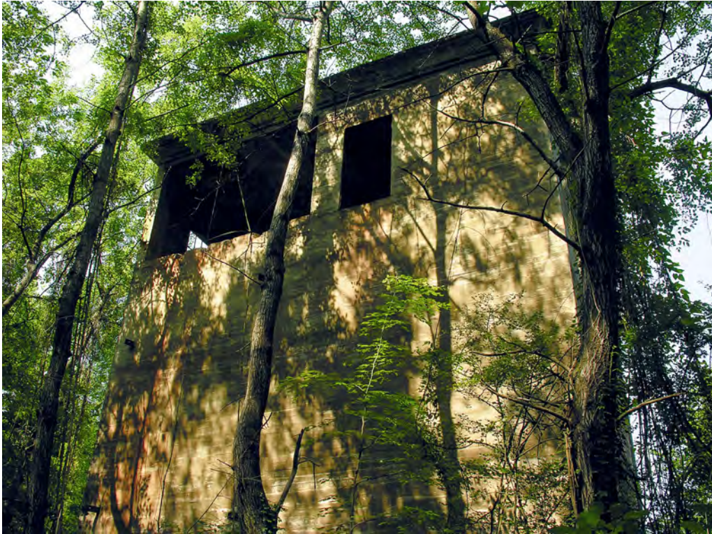
1: Das ehemalige Roherzsilo des Südfeldes auf Gemarkung Ebringen – heute.
