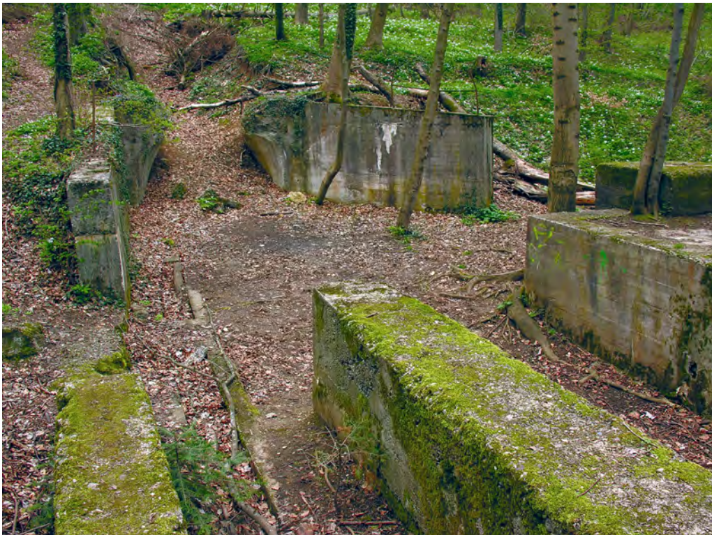
2: Die langlebigen Betonfundamente des ehemaligen Mösleschachts oberhalb St. Georgen – heute.
