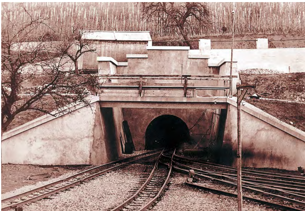
2: Der sogenannte Eisenbahnstollen z.Zt. des Betriebes – vor Anbringen des Freskos von Riedlin (LGRB).
